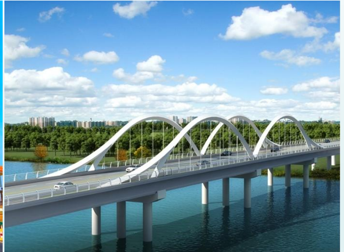
Металлический арочный мост Nanyang Wantong (500t)
