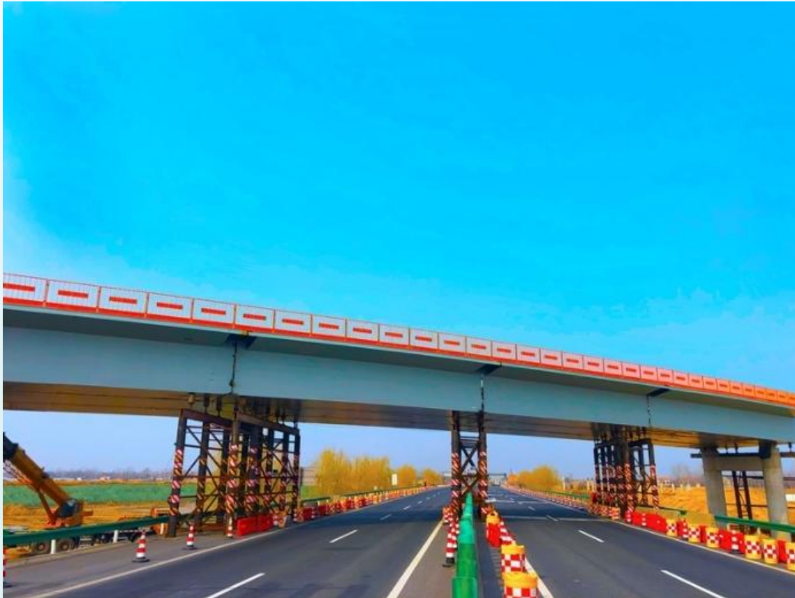
Металлическая конструкция для строительства автомобильного моста
