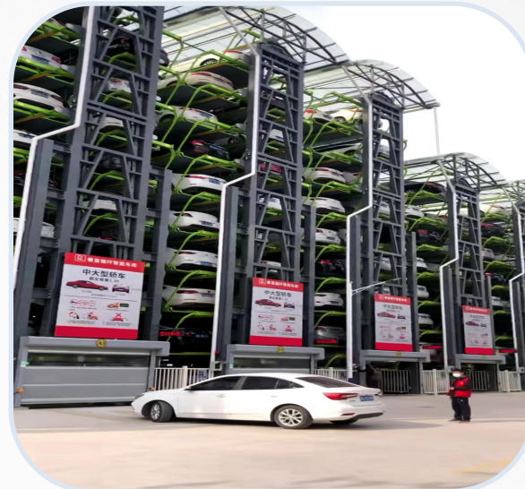
▼ 多氟多化工立体车库
