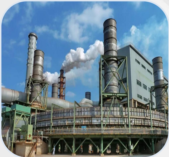
▼ 钢厂环冷机 烧结机 输送机
